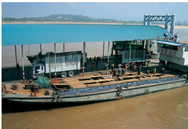
チェンセン港に完成した全天候型の荷揚げ設備。直接トラックを貨物船の舷側に乗り入れることができるようになったほか、水位の増減に応じて荷揚げが可能になった。(右：2009年2月撮影／左：2006年2月撮影)
