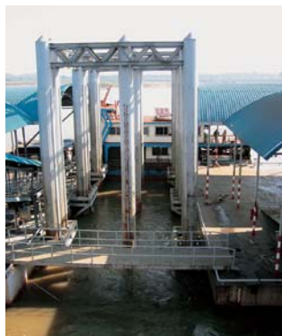
チェンセン港に完成した全天候型の荷揚げ設備。直接トラックを貨物船の舷側に乗り入れることができるようになったほか、水位の増減に応じて荷揚げが可能になった。(右：2009年2月撮影／左：2006年2月撮影)
